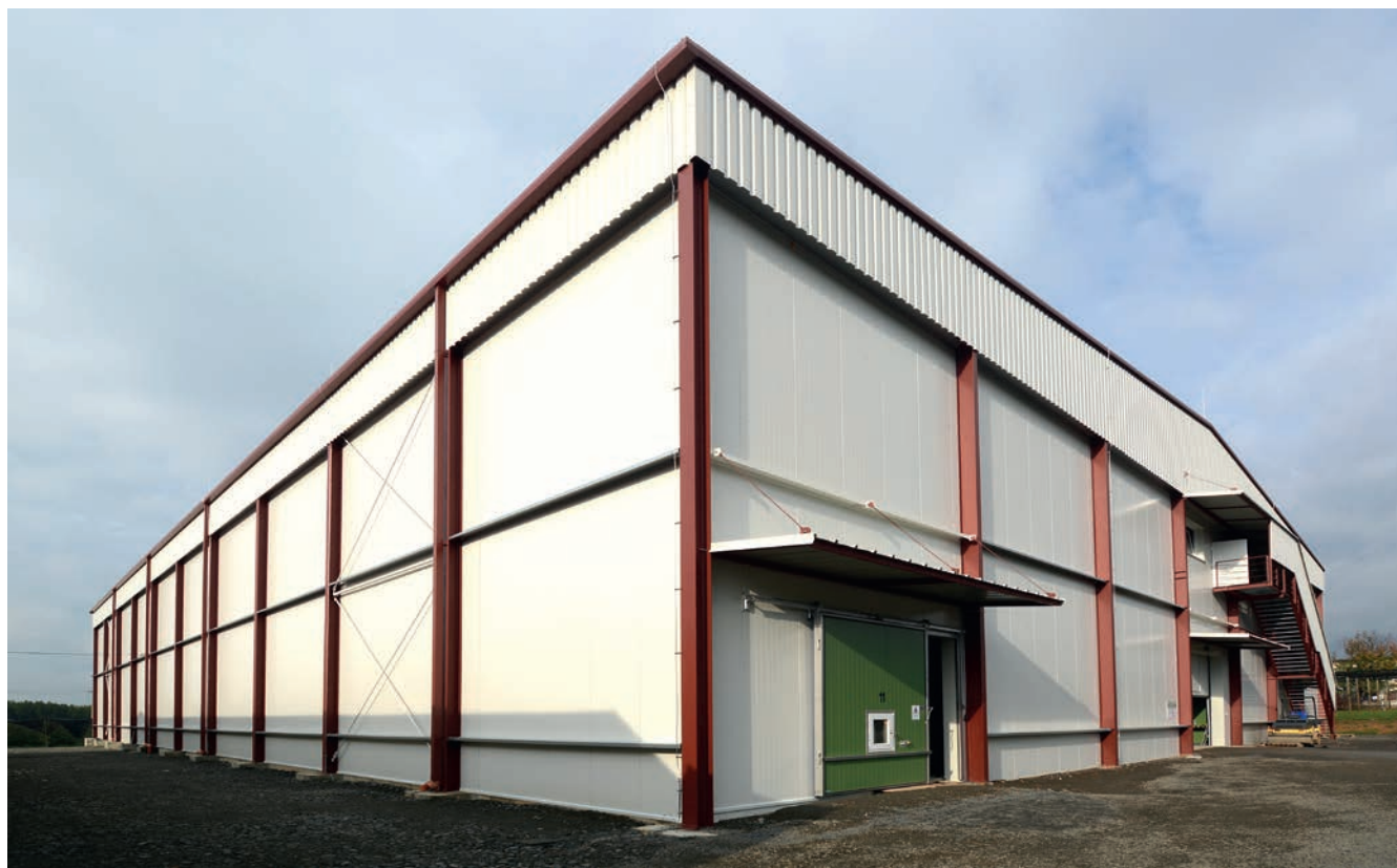
Konstrukce haly je přiznaná s panely kotvenými zevnitř.
