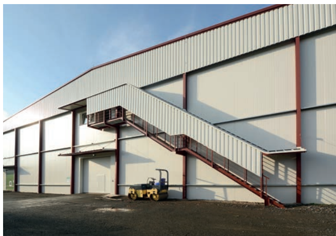
Čelní strana haly se schodištěm do patra
