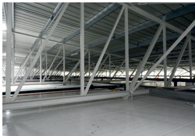
Přhradový vazník se zavěšeným podhledem
