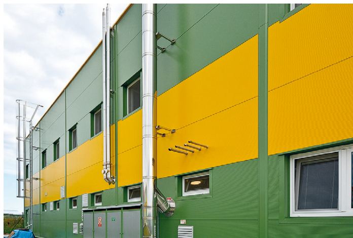
Výrobní hala potravinářských produktů SEMIX PLUSO.
